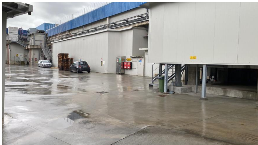
Panoramica generale della sala macchine 2
